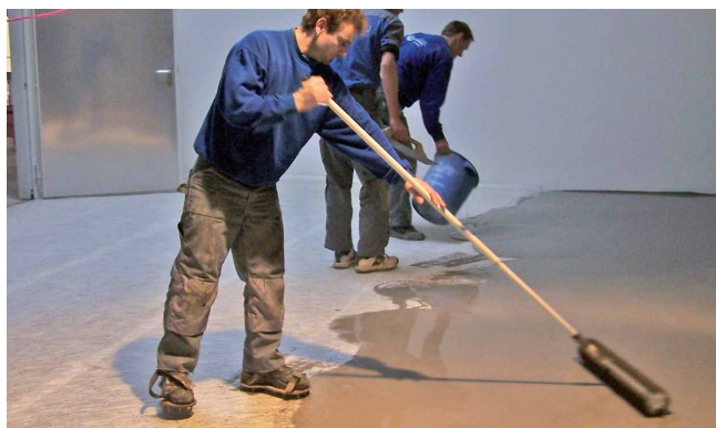
Verarbeitung von UZIN NC 170 LevelStar auf lose ausgelegtem Renoviervlies UZIN RR 201
