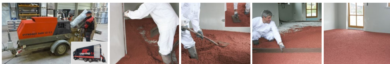
1 Sack (200 Liter) mit 10 - 12 Liter Wasser (je nach Produkt) in Estrichpumpe zu einer homogenen Dämmung mischen (mind. 2 Min. Mischzeit).
